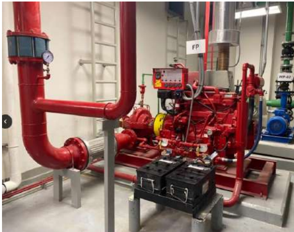
ระบบน้ำสำรอง และ Fire Pump
